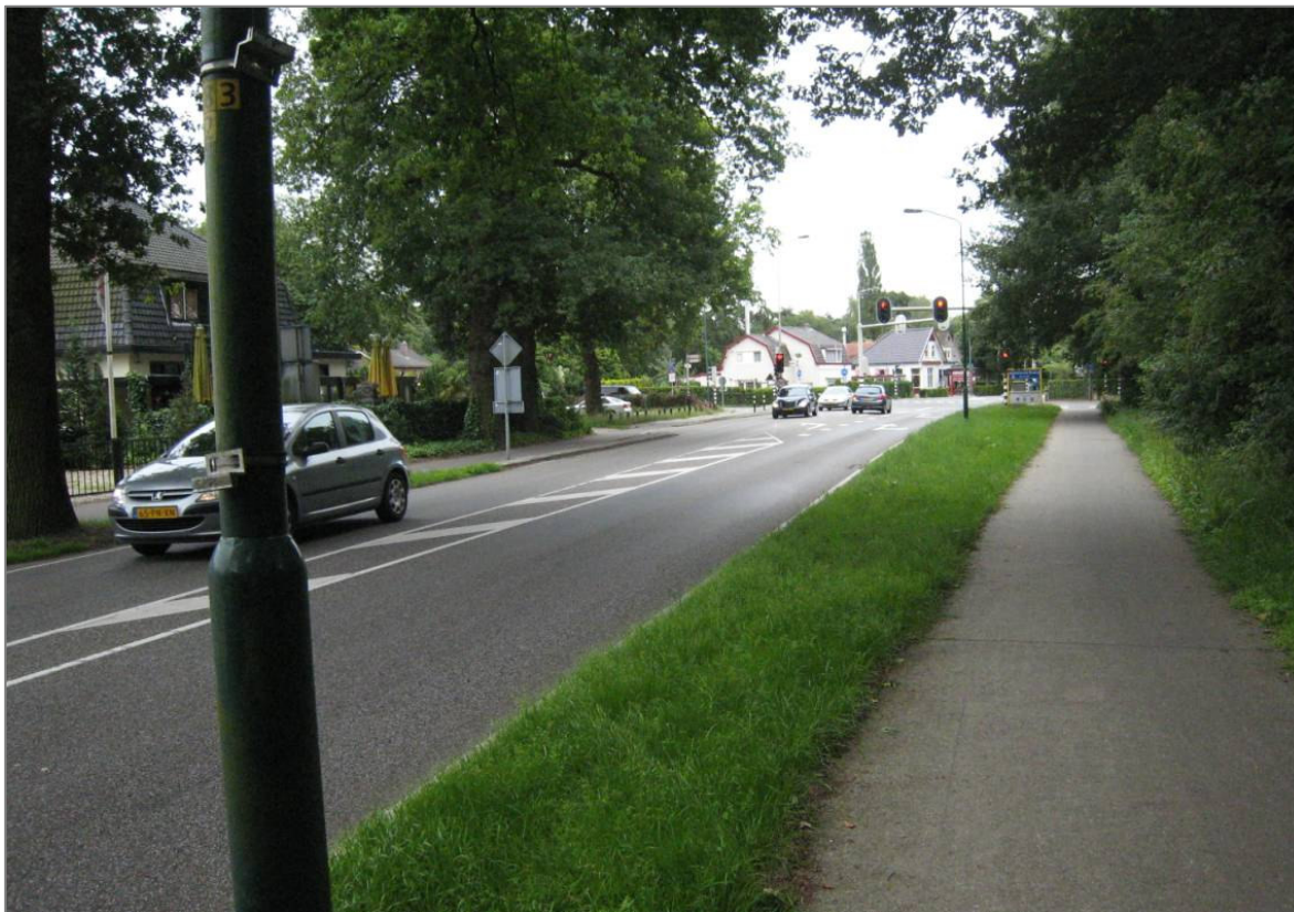
Figuur 3 N417, kijkend in richting de Graaf Floris V weg / Vuurse Dreef (rechter weghelft watert af op berm; linker weghelft watert af via kolkleiding)
