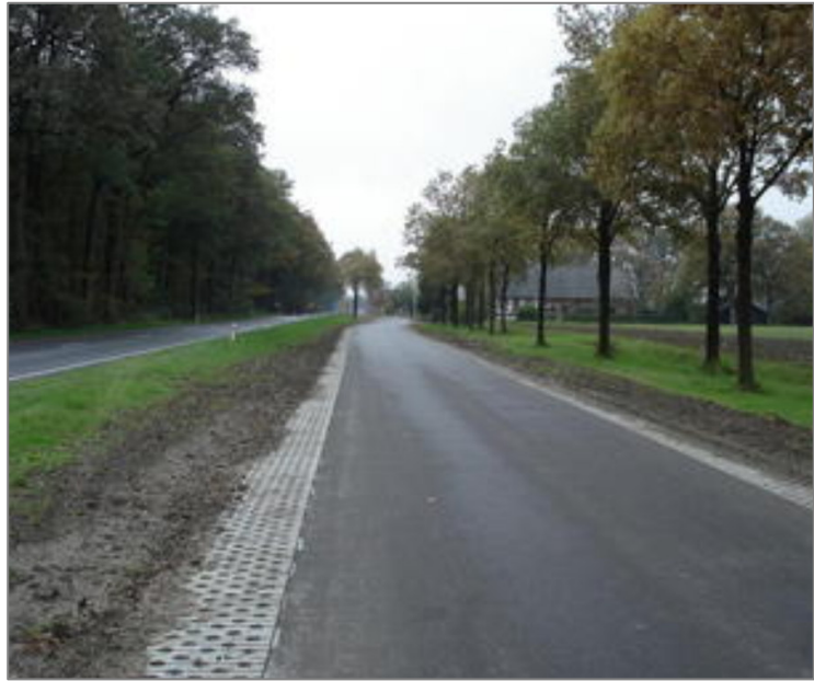
Figuur 4 Voorbeeld toepassing bermverbandblokken
