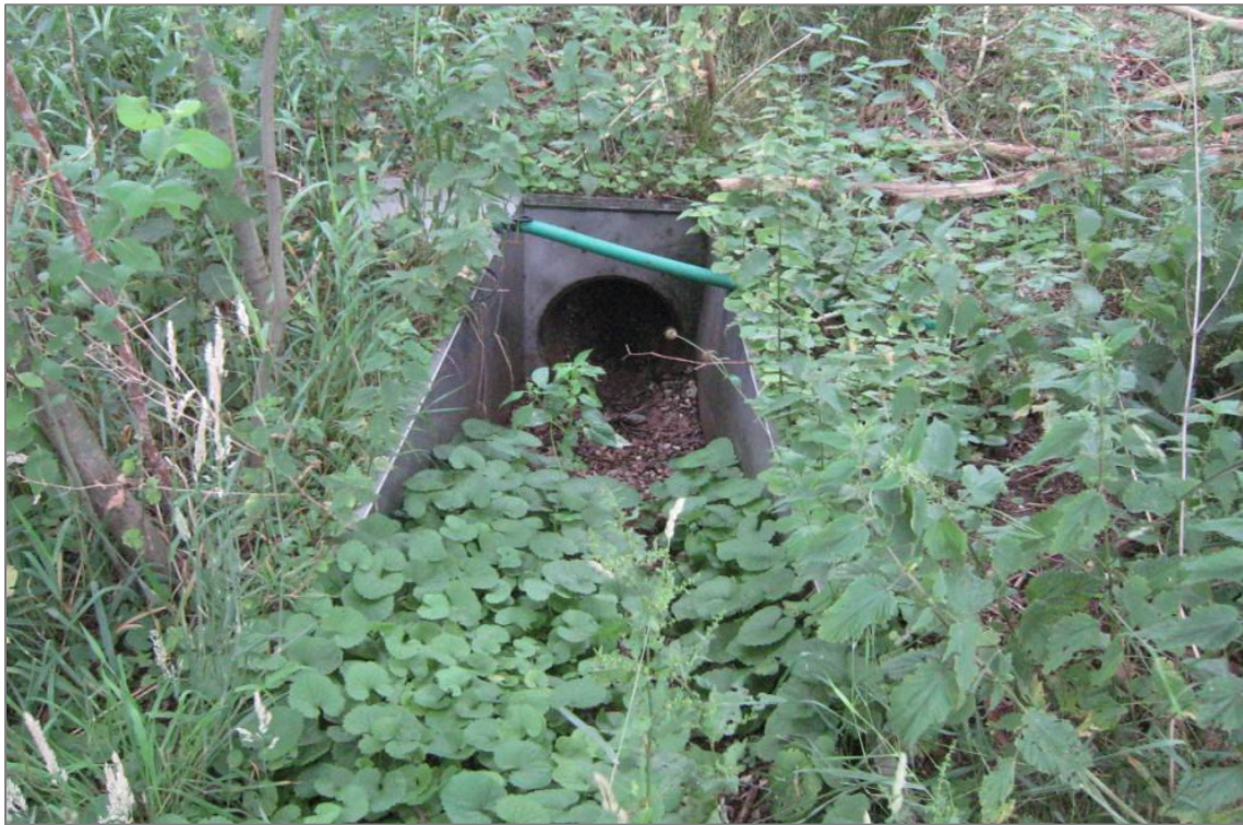
Figuur 6 Dassentunnel in watergang aan westzijde N417 (halverwege Km 8,500 en Km 8,600)
